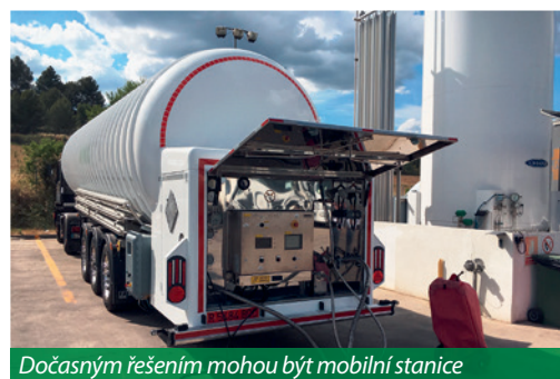
V Německu provozuje pevnou LNG stanici firma Liqvis u Berlína a v Kasselu
